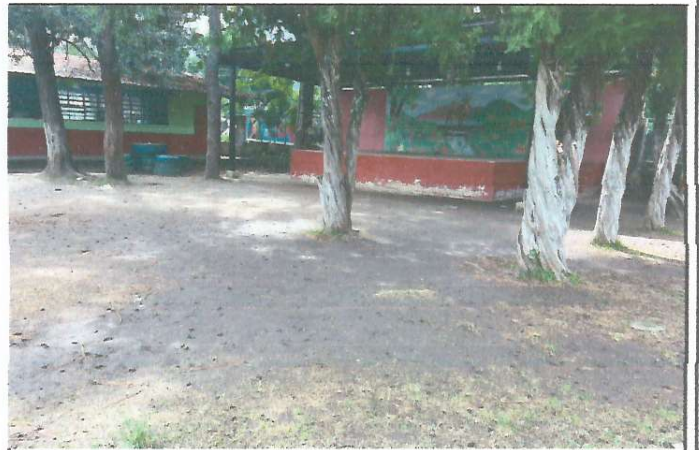
Foto 4: Mejoramiento de losa de patio.
