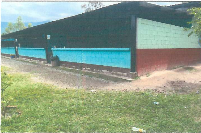
Foto 3: Mejoramiento de banqueta peatonal a escuela.
